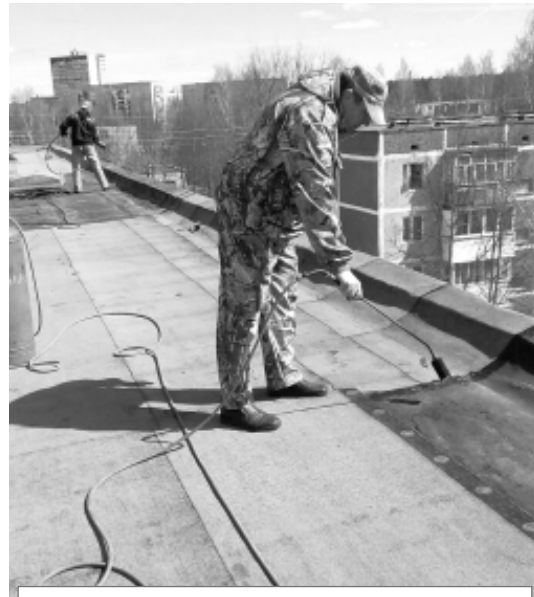
Мастер по обслуживанию зданий и сооружений Андрей Отвагин проводит текущий ремонт крыши.
