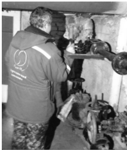
Мастер по обслуживанию зданий и сооружений Павел Прохоров проводит осмотр инженерных коммуникаций, расположенных в подвале жилого дома.
