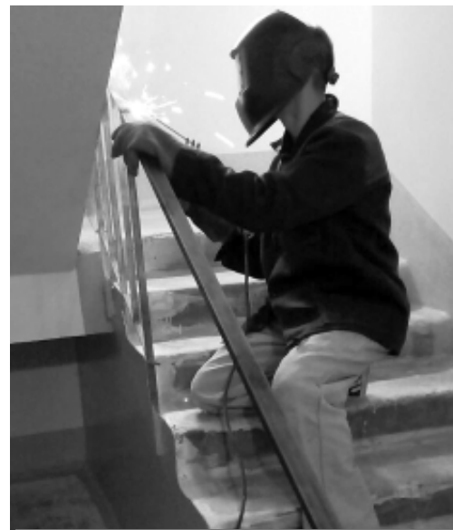
Мастер по обслуживанию зданий и сооружений Евгений Тайлаков проводит сварочные работы в подъезде дома.
